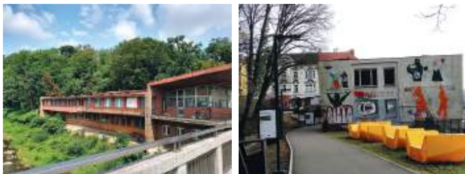
Ryc. 38. Budynek straży granicznej i służb celnych – widok z Mostu Przyjaźni i od strony Al. Piastowskiej
